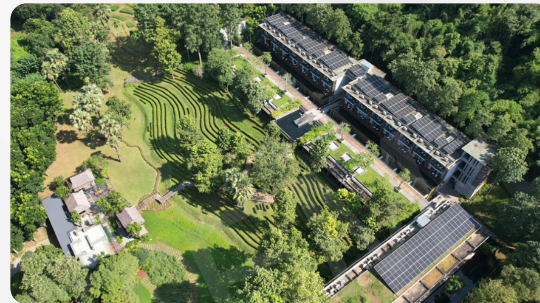
135.30 kWp โรงแรมวิวัฒนา เชียงใหม่
