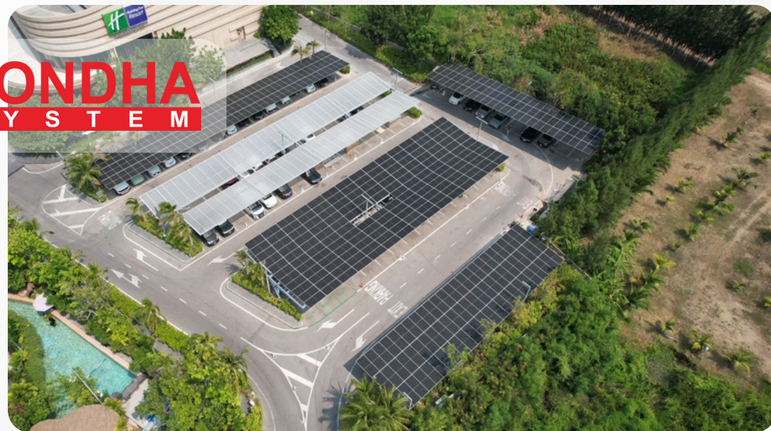
361.76 kWp โรงแรมฮอลิเดย์ อินน์ Holiday INN
