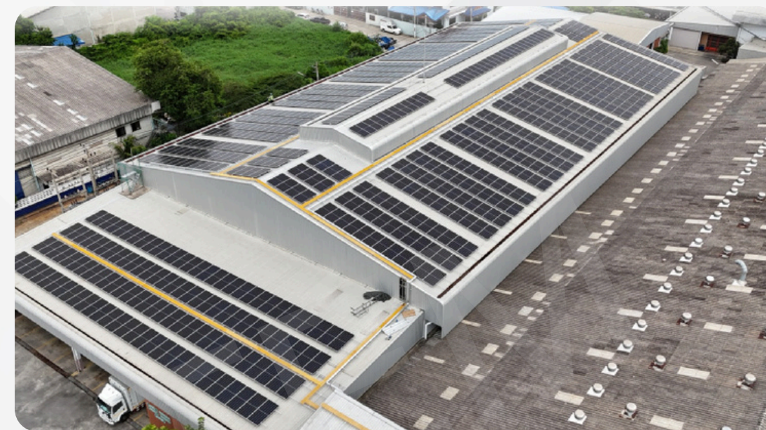
448.80 kWp บริษัท ยูโนเต็ด คอนเทนเนอร์ จำกัด
