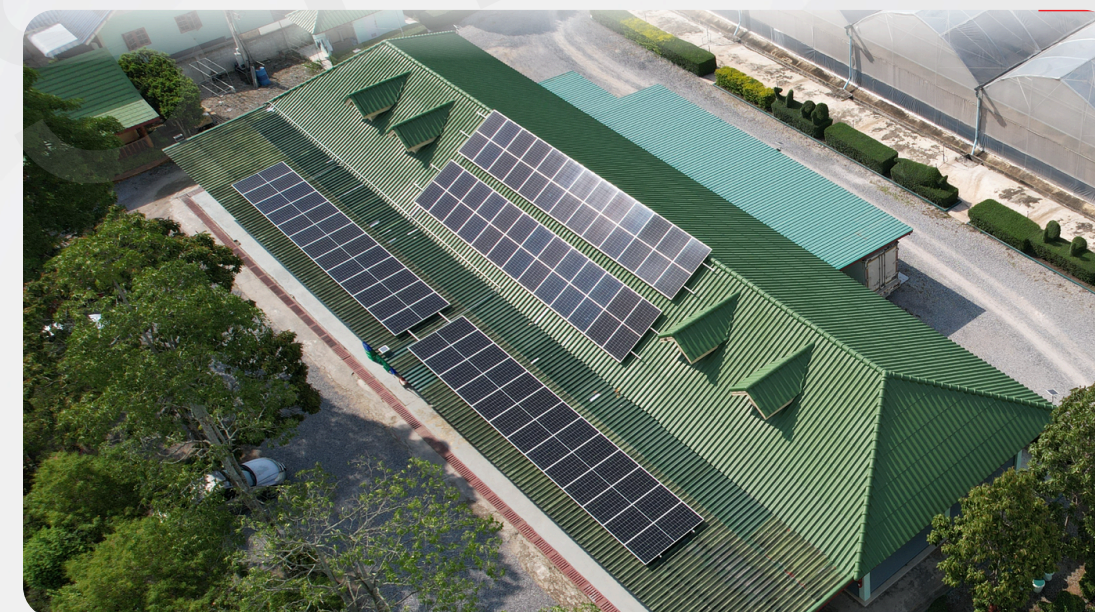
30.68 kWp บ้านไร่ปวริศ
