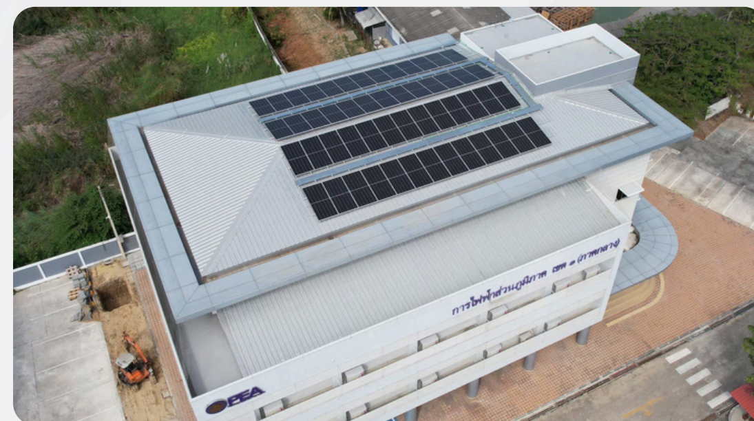
32.24 kWp การไฟฟ้าส่วนภูมิภาค ก.1 อาคารฟลว.
