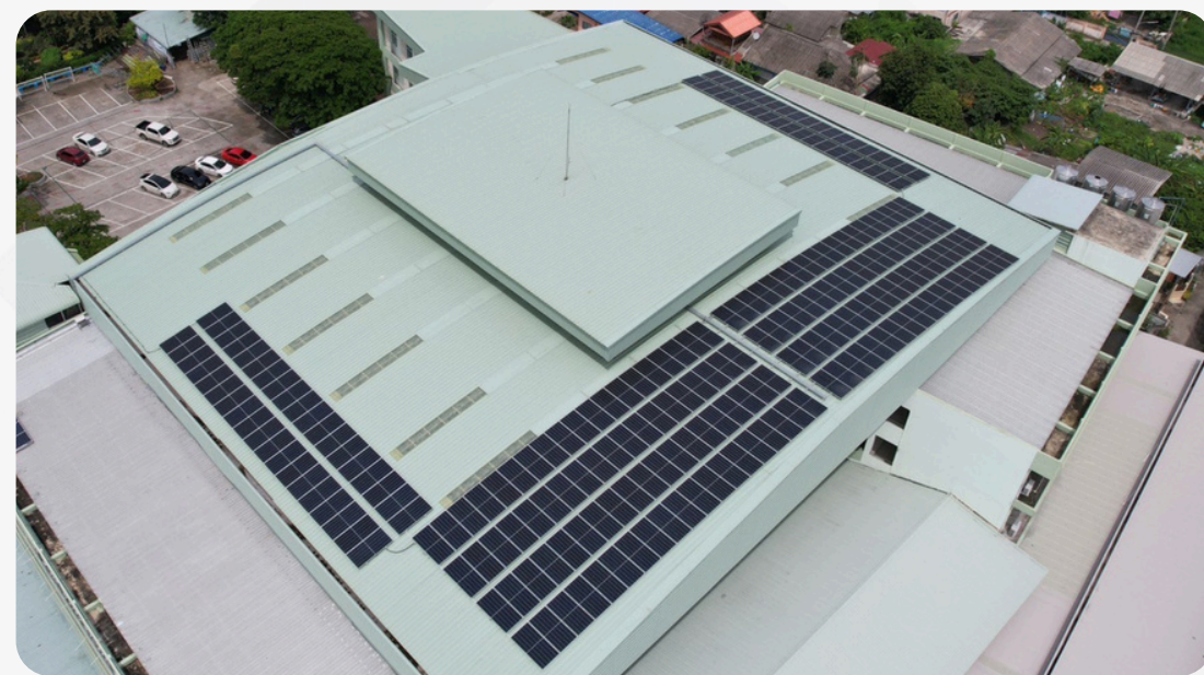
102.60 kWp โรงเรียนอัสสัมชัญคอนแวนต์ ลพบุรี
