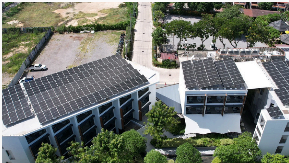
118.80 kWp เวอร์โซ หัวหิน - A Veranda collection
