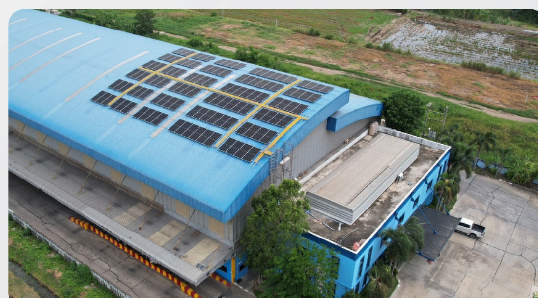
66 kWp บริษัท บางกอกค้าเหล็ก จำกัด
