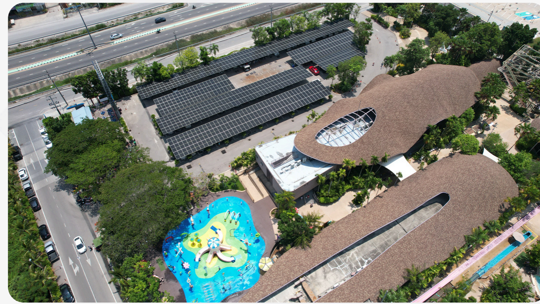
396.27 kWp สวนน้ำวานา นาวา วอเตอร์จังก์ชั่น
