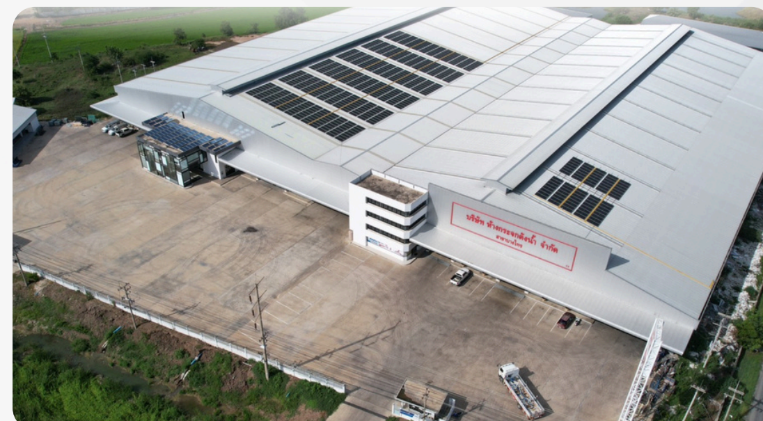
358.05 kWp บริษัท ห้างกระจกตังน้ำ จำกัด สาขาบางไทร
