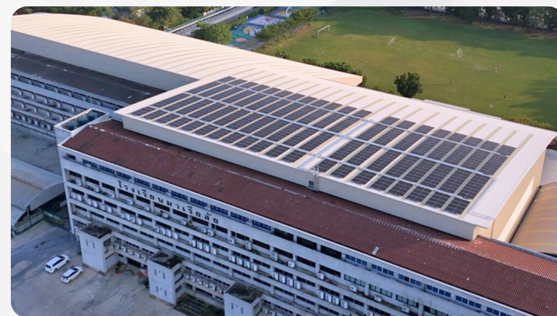
300 kWp โรงเรียนมาเรียลัย กรุงเทพฯ
