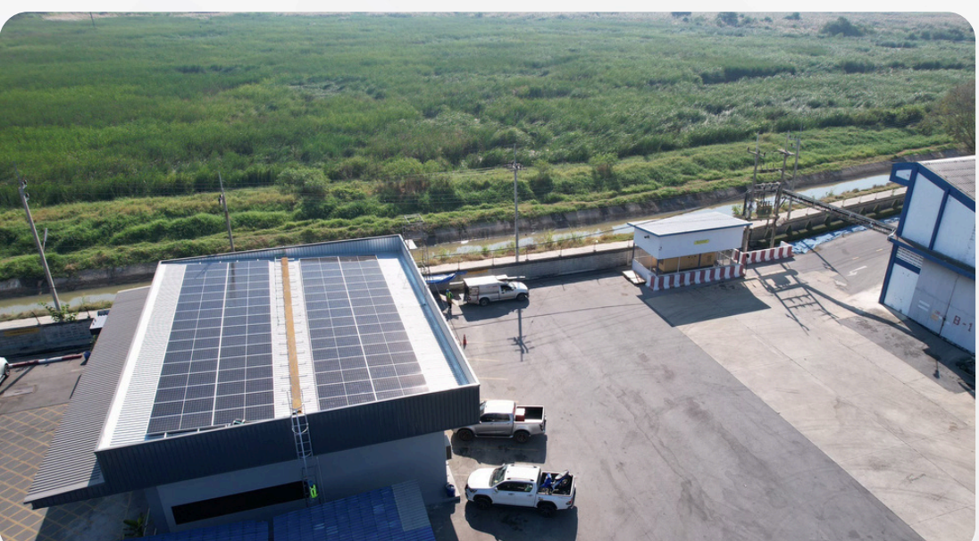
40 kWp บริษัท เจียใต้ จำกัด สาขาบางไทร
