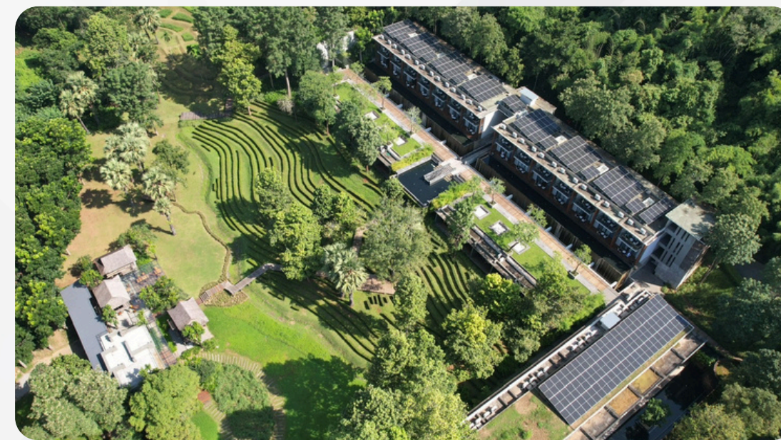
135.30 kWp โรงแรมวิรันดา เชียงใหม่
