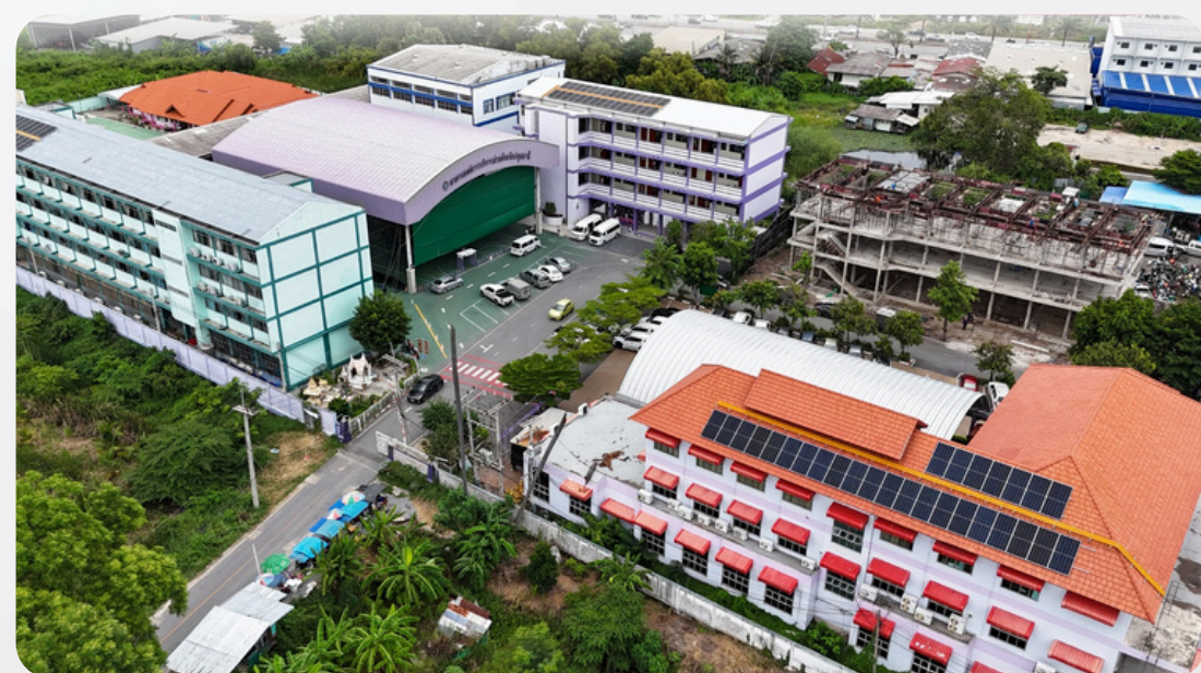
45 kWp โรงเรียนเทศบาลเมืองปทุม
