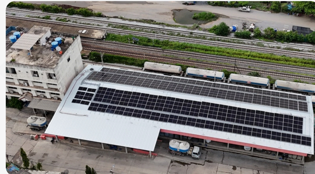
172.50 kWp TPI ศูนย์จ่ายแปรง ฉะเชิงเทรา
