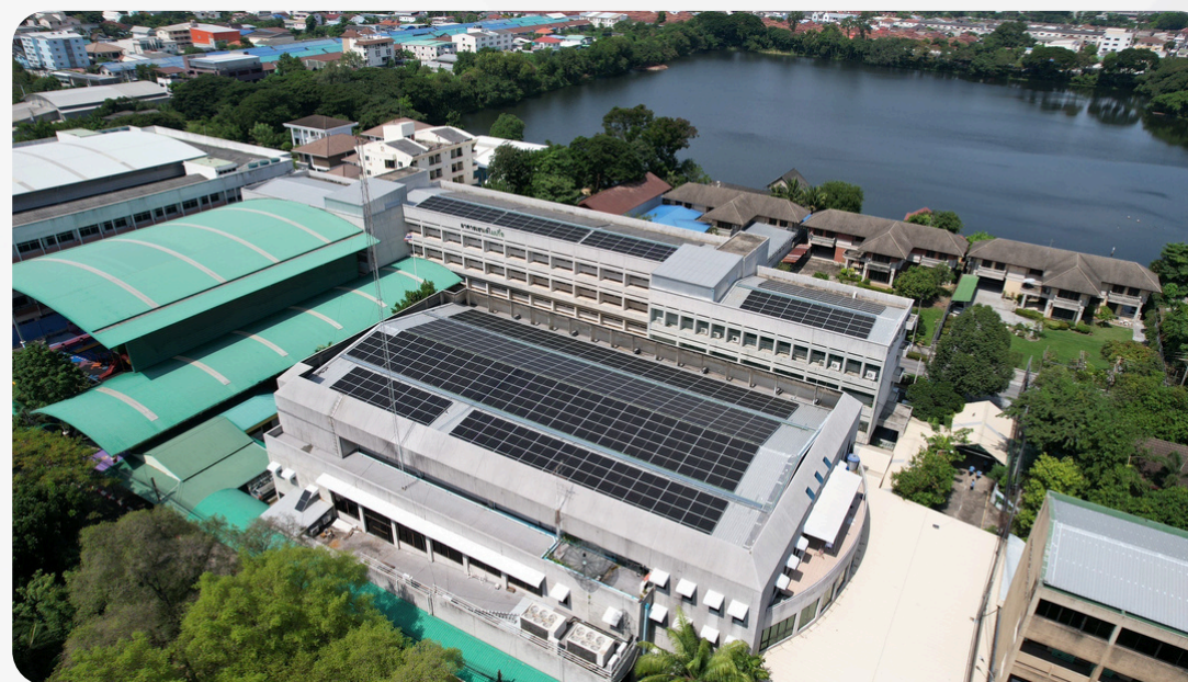
300 kWp โรงเรียนพระมารดาปิอานูเคราะห์ กรุงเทพฯ
