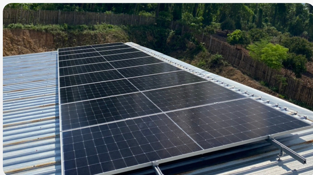
5 kWp 10 kWh วัดพระแม่รับเกียรติขึ้นสู่สวรรค์
